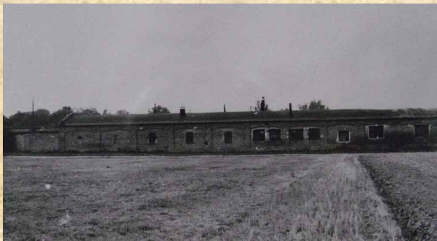
Widok na stodołę – elewacja północna (źródło: WUOZ Konin)
