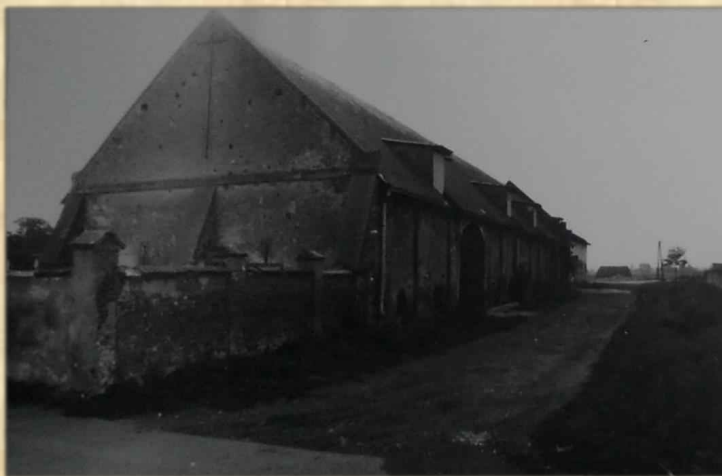
Stary mur w północno-zachodnim narożniku podwórza i stodoła w części zachodniej (lata 90.) (źródło: WUOZ Konin)
