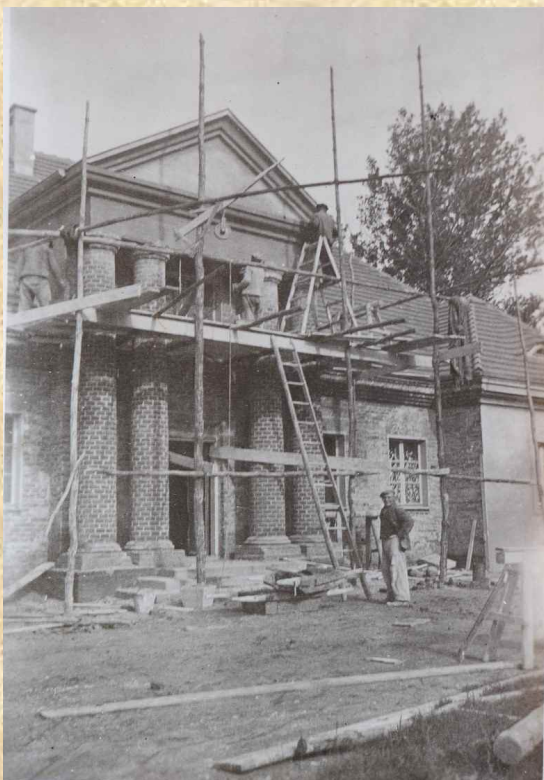
Prace wykończeniowe przy dworze w czasie II wojny, kiedy właścicielem był Niemiec (zbiory własne autora)
